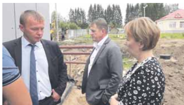
На стройплощадке в Грузинах.
