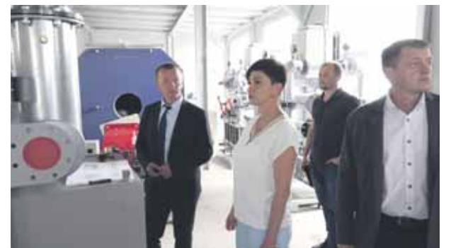
На новом объекте в Торжке.
