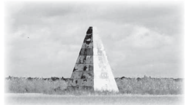
12-метровое сооружение на окраине посёлка.
